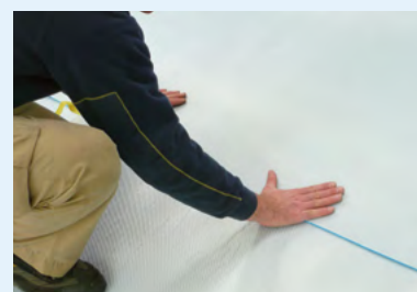
Assurer une bonne adhésion du recouvrement
